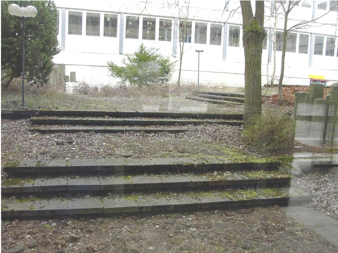
Sanierung und naturnahe Umgestaltung des Innenhofs der Realschule Emmelshausen
