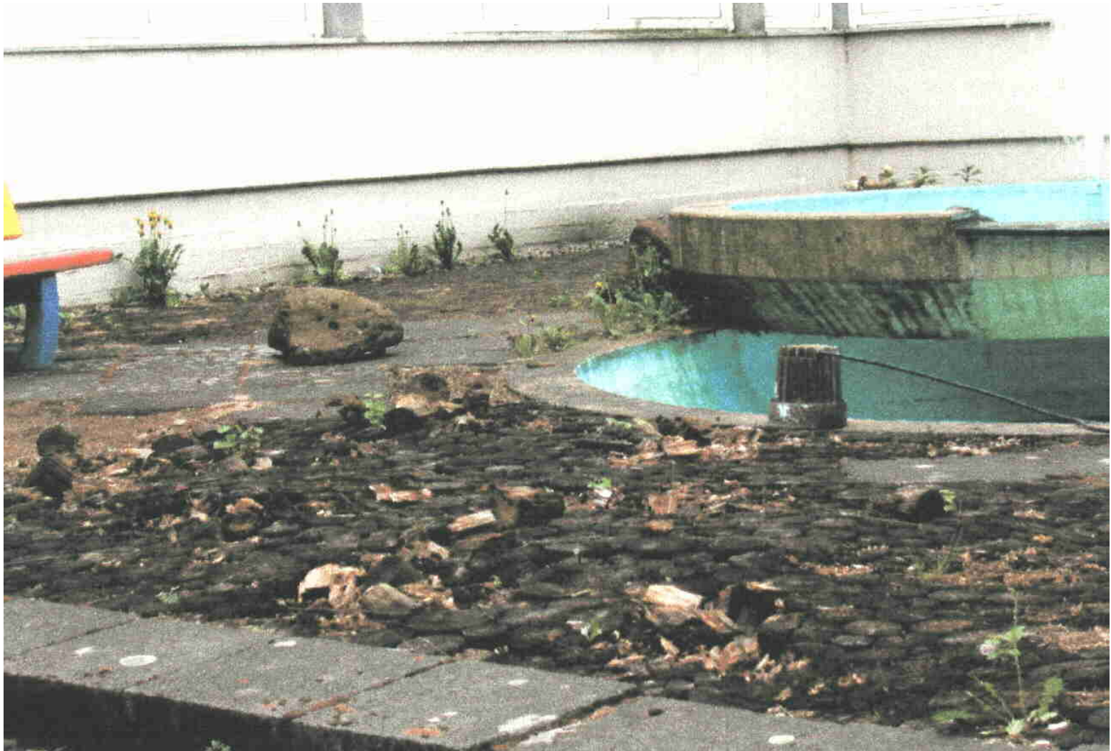
Sanierung und naturnahe Umgestaltung des Innenhofs der Realschule Emmelshausen
